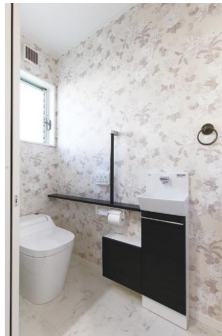
引戸への変更と手摺が一体となった手洗いカウンターを設置したバリアフリースイートイレ。
