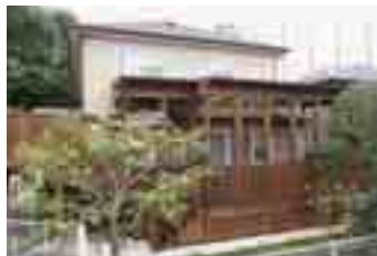
庭の木と調和したウッドデッキ。
